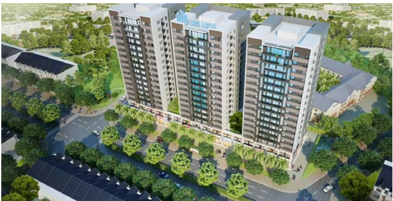
Khu dân cư Sông Đà IDC TOWER - TP. Hồ Chí Minh
