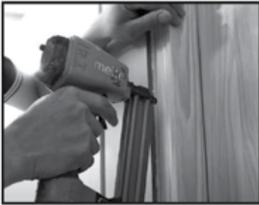
Bước 7: Cân chỉnh lắp cây khung bao còn lại Step 7: Adjust and install the other vertical frame
