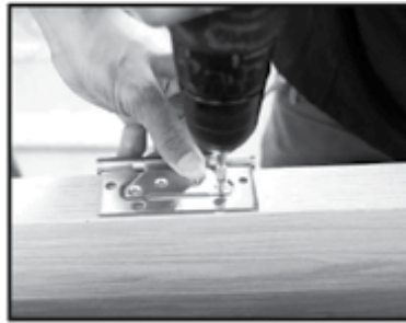
Bước 5: Bắn 3 bản lề vào cánh cửa theo đúng khoảng cách quy định Step 5: Install the 4 hinges to the door panel with the distance shown in the drawing.
