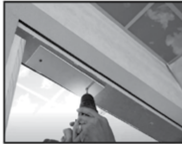
Bước 8: Lắp cây khung bao ngang Step 8: Install the horizontal frame.
