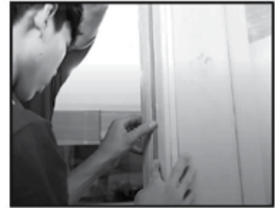
Bước 9: Lắp ron giảm chấn, giảm tiếng ồn cho cửa Step 9: Install the plastic seal to damp and soundproof.
