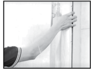
Bước 6: Lắp cánh lên cây khung bao đã bắn lên tường Step 6: Install the door panel to the installed frame.
