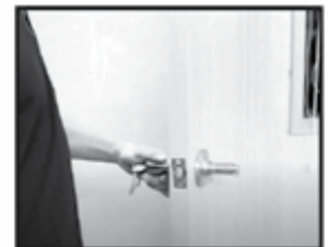
Bước 13: Kiểm tra cửa và vệ sinh. Step 13: Recheck and clean the door
