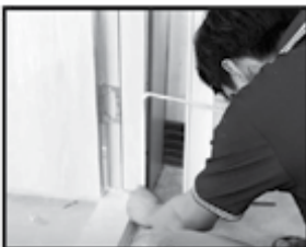
Bước 10: Đo cắt nẹp viền và gắn nẹp vào khung bao Step 10: Measure and cut the trims, then install them to the frame.
