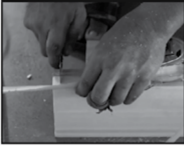
Bước 1: Cắt khung bao đứng theo chiều cao đo đạc Step 1: Cut the frames as the measured height.
