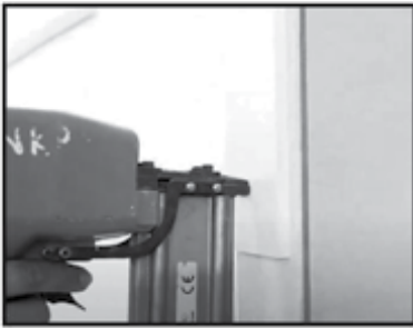
Bước 4: Lắp cây khung phía bên bản lề trước Step 4: Install the hinge side frame first.
